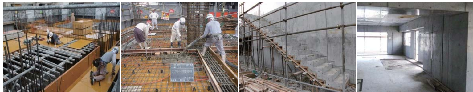
スラブ（床）型枠組立 コンクリート打設 壁階段型枠外し 型枠及び支保工外し後
