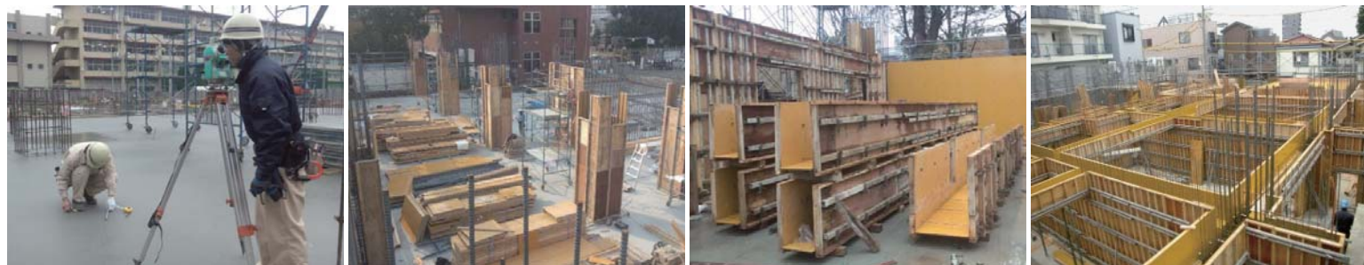
墨出し 柱型枠組立 梁型枠地組 梁型枠組立
