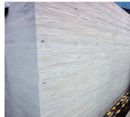
▲杉板を型枠として使用
