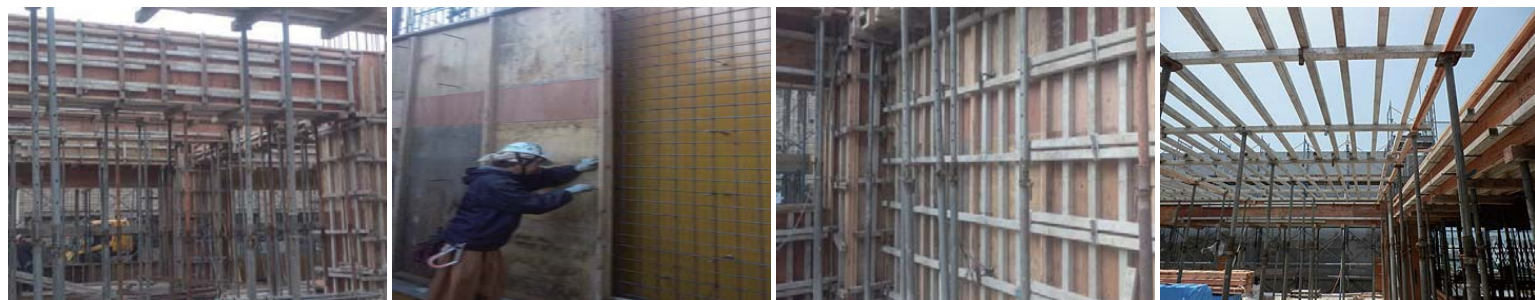
梁支保工組立 壁型枠組立 壁型枠返し固め スラブ型枠支保工組立
