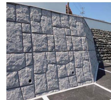
▲石垣に模した発泡スチロールを型枠の内側に使用
